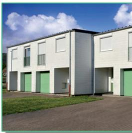
Dès que les premiers manteaux sont produits, ils sont expédiés sur le chantier pour être posés. La production se fait ainsi en temps masqué, parallèlement à la pose des modules. Le temps moyen de rénovation de la cité est divisé par 4 comparé à une solution classique.
